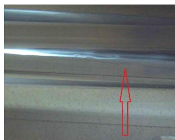
Beelden van een scheurvorming in een ES-las (links) en een horizontale scheurvorming puntstuknaald (rechts) uit het huidige videoschouwsysteem.
