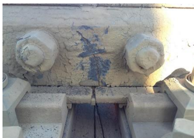
Beelden van een scheurvorming in een ES-las (links) en een horizontale scheurvorming puntstuknaald (rechts) uit het huidige videoschouwstelsel.
