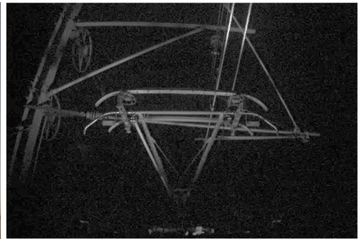
Figuur 5. Voorbeeld Bovenleidingbeeld in de nacht.
